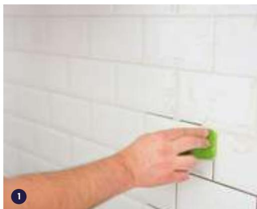
**2** Se deja secar ligeramente entre 20 - 30 min y cuando la pasta se seque se vuelve mate, se limpia la superficie con una esponja ligeramente humedecida. Solo cuando el producto haya endurecido se podrá limpiar la superficie con un trapo limpio y seco para eliminar los restos de polvo.
